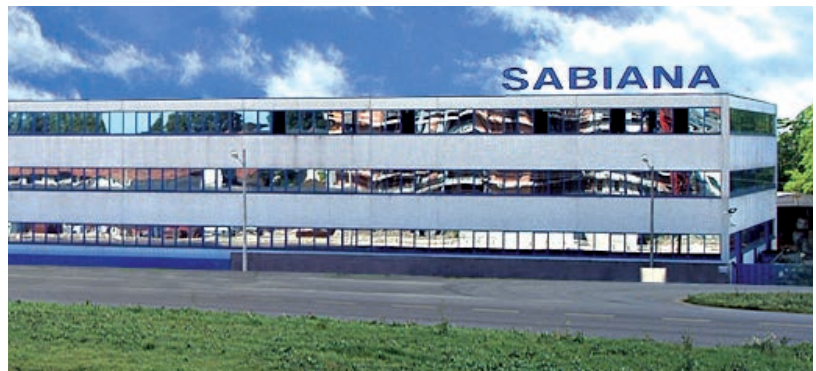
Usine de Corbetta
