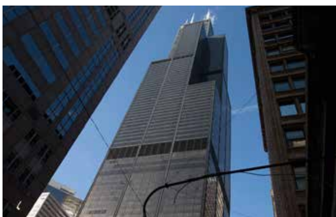
Willis Tower - USA - Clima Canal
