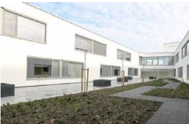
WZC Vinkenbosch - Belgium - Strada & Oxygen
