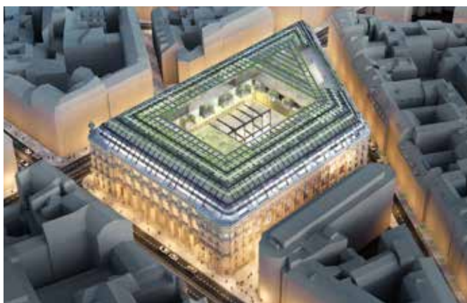
Poste du Louvre - France - Clima Canal
