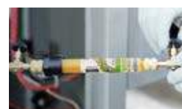
Injection simultanée avec le fluide frigorigène.
