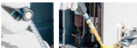
Injection du colorant en tournant la poignée.
