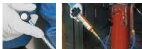
Injection du colorant en tournant la poignée.
